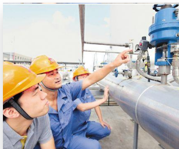
河道/管道巡检
